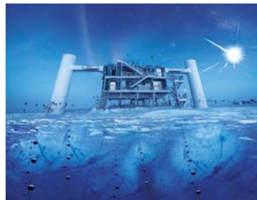
IceCube ist das größte Neutrino-Observatorium der Welt und liegt direkt am Südpol. Die Teilchen werden von Detektoren erfasst, die ins Eis eingelassen sind.
