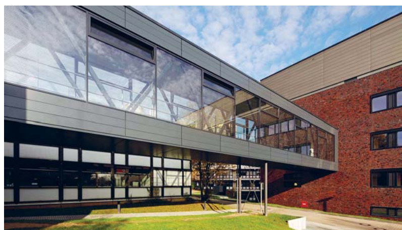
Im Ersatzneubau Chemie/Physik sind zahlreiche Labore, Praktikumsräume und ein Großgerätezentrum zu finden. Das Gebäude wurde im Sommer 2015 eröffnet. Foto: Andreas Secci
