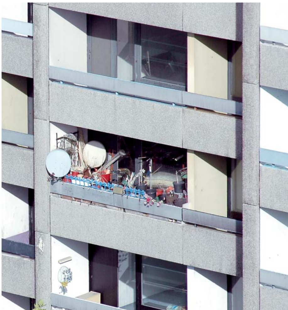
Eine Herausforderung für Planerinnen und Planer: Leerstehende Siedlungen
