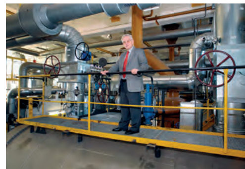
Prof. Edmund Handschin ist 1974 Gründer des Bereichs Energieversorgung, aus dem das Institut für Energiesysteme, Energieeffizienz und Energiewirtschaft (ie3) hervorgeht.
