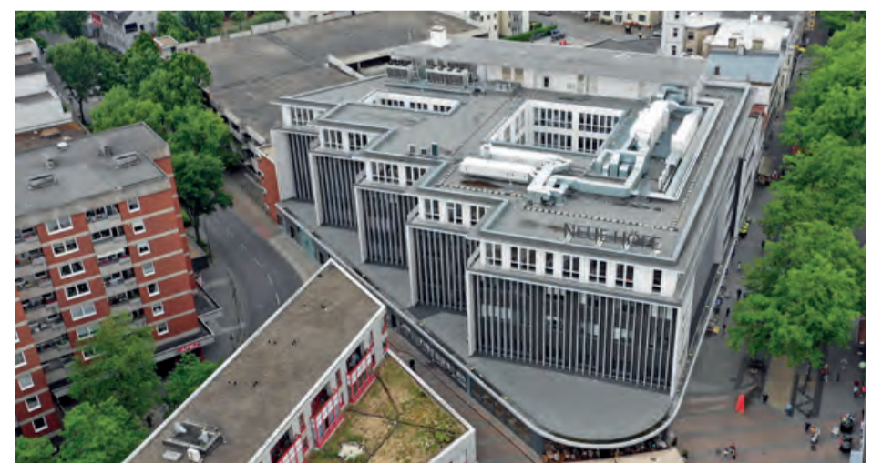
Aus einem ehemaligen Warenhaus in Herne sind die „Neuen Höfe“ entstanden – mit Büros, Gastronomie, Gewerbe und Sportangeboten. Foto: Andreas Steindl/Landmarken AG
