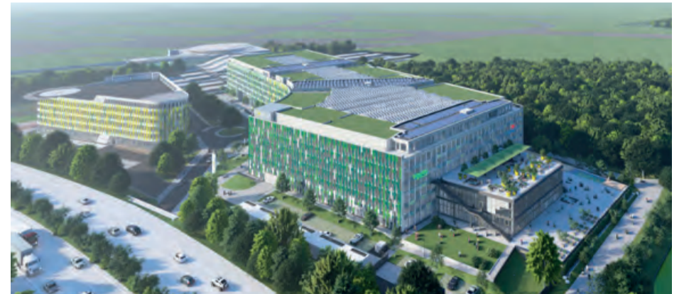
Der neue EUREF-Campus entsteht am Fernbahnhof des Flughafens Düsseldorf. Foto: EUREF AG
