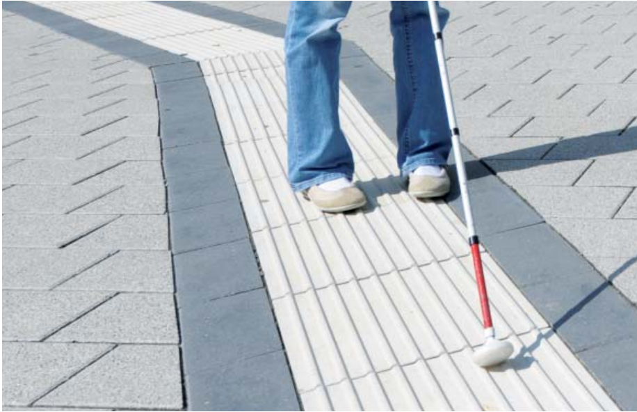
Gehwege, die an die Bedürfnisse von Menschen mit einer Sehbehinderung angepasst sind, erleichtern diesen bereits vielerorts den Alltag.
