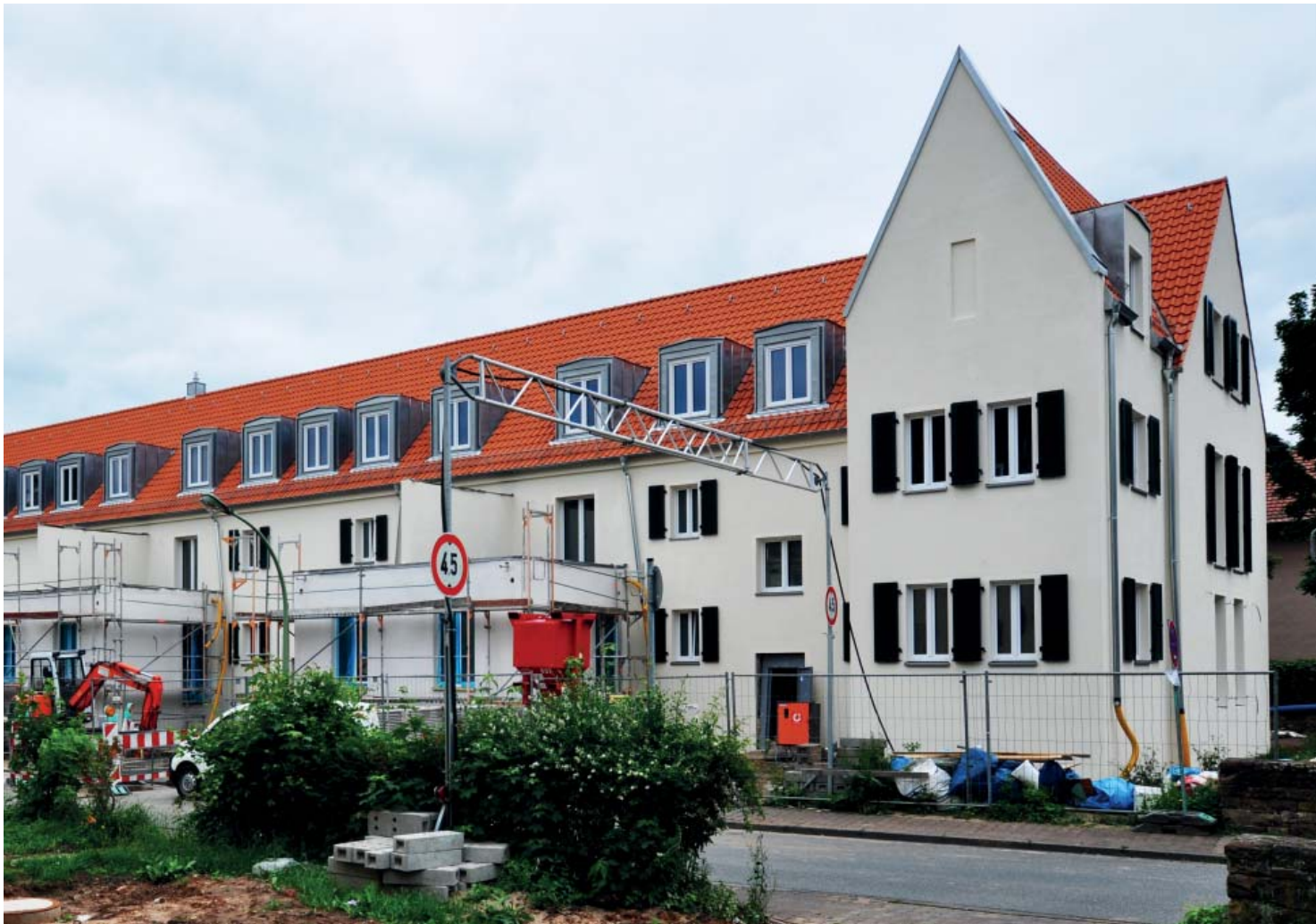
Häuserzeilen in der Siedlung Frankfurt Riederwald wurden nach den Plänen des Instituts für Stadtbaukunst saniert – dadurch stieg die Lebensqualität.
