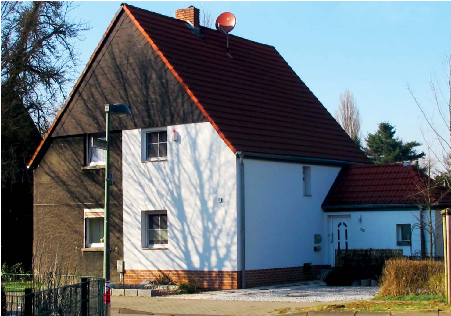
Sanierungsmaßnahmen können die ursprüngliche Architektur stark beeinträchtigen. So werden dabei zum Beispiel historische Bauelemente überdeckt.
