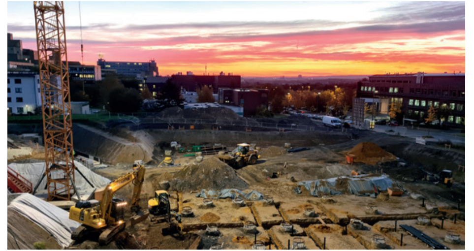
Auf der Baustelle an der Otto-Hahn-Straße schreiten die Arbeiten voran. Foto: Martin Kaiser
