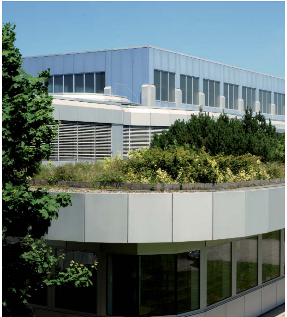
Begrünte Dächer sorgen für eine klimatische Abkühlung des Gebäudes.
